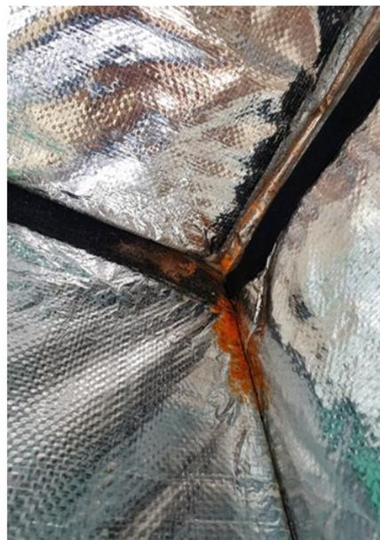
Figura 3. Dettaglio di residuo alimentare in corrispondenza dell'angolo del contenitore
