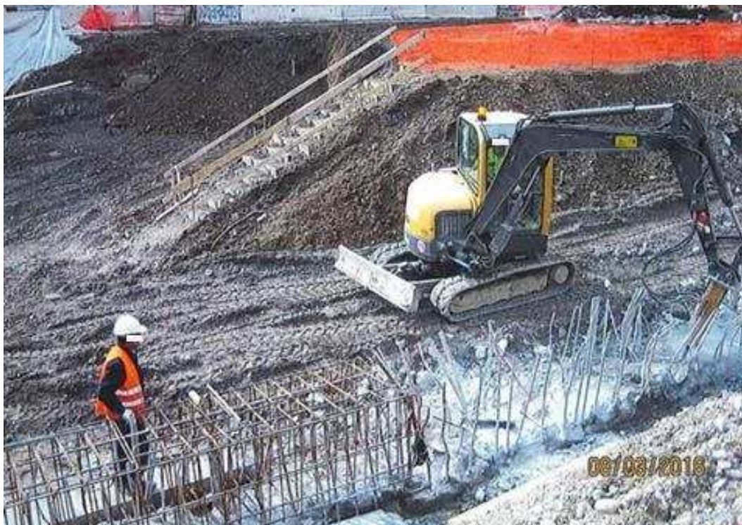
Foto 1: scapitozzatura diaframma e potenziale interferenza con fase di armatura e cassetatura
