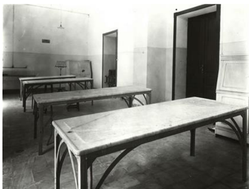
Fig. 11 - Sala anatomica per le esercitazioni degli studenti, all'interno dell'Istituto di via Porcell all'epoca di Castaldi. Si osservino i tavoli anatomici con piano di lavoro in marmo, inclinato e dotato di tubo di collegamento allo scarico fognario (cortesia del prof. A. Riva).
