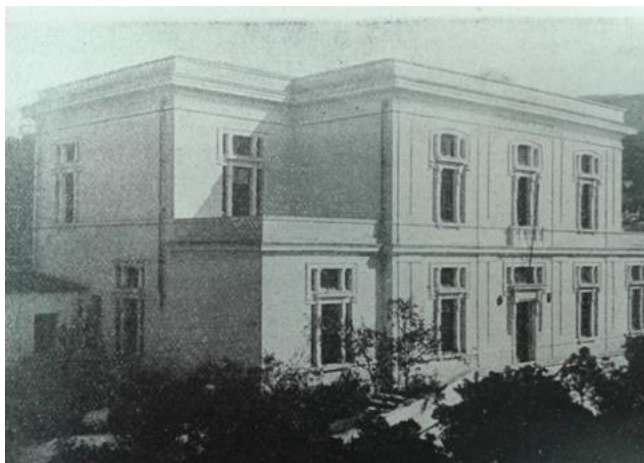
Fig. 10 - Istituto di anatomia umana normale di Cagliari, via Porcell, appena costruito (1922).
