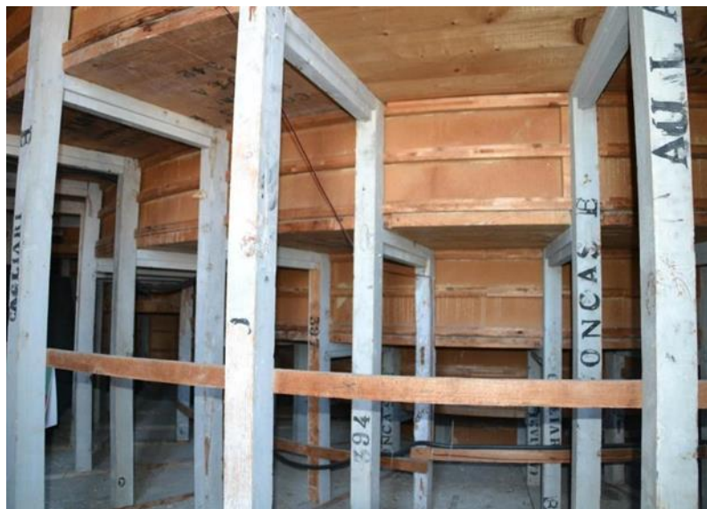
Fig. 14 - Struttura lignea di sostegno nel sotto-teatro. Da notare la numerazione dei pezzi, il nome del committente (Concas E.) e la città di destinazione (Cagliari) (fotografia di Marcello Trucas).
