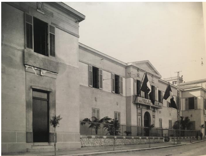
Fig. 2 - Il prospetto dell'edificio dell'Infanzia Abbandonata di via delle Croci a Palermo.
