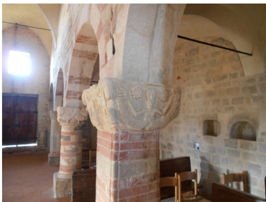
Fig. 2 – Chiesa romanica di San Secondo a Cortazzone (Asti). Interno. Capitello del secondo pilastro a nord: vista verso ovest (foto dell'autore).
