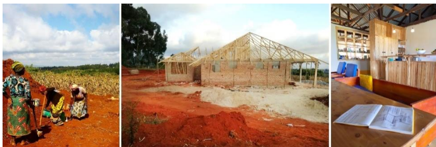
Figura 3 – Tovini Foundation Center: Fasi di cantiere (Elaborazione
