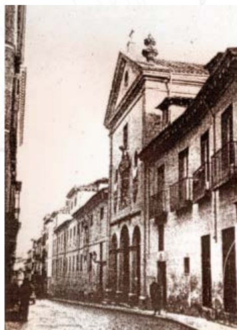
Iglesia y convento de las Trinitarias. Aquí yacen los restos de Miguel de Cervantes y aquí profesó y está enterrada Sor Marcela de San Félix.
