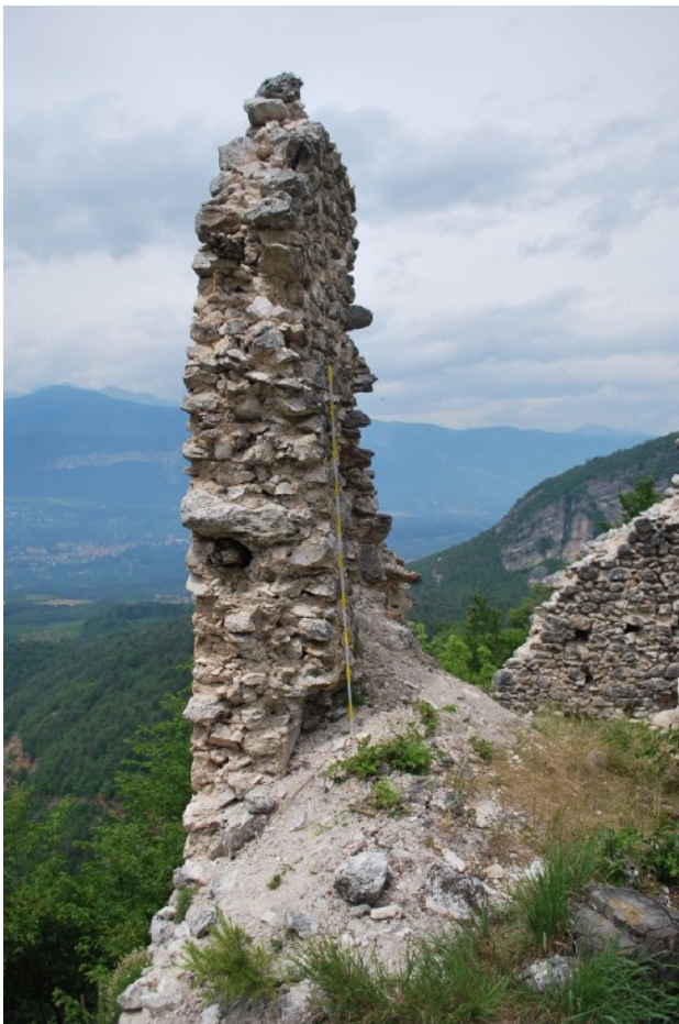
Figura 17: Castel San Pietro, Vigo di Ton (TN). Sezione della prima cinta che presenta conservate in situ travi a sezione circolare ad intervallo di 1,5 m.
