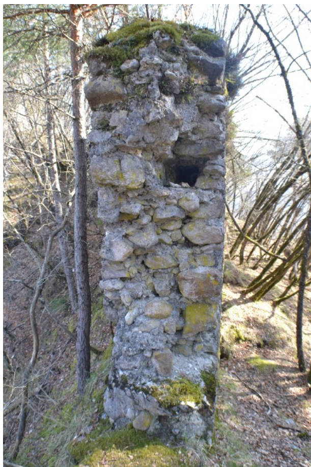
Figura 15: Castel Flavon, Flavon (TN). Sezione del muro di cinta dove permane traccia di una trave a sezione rettangolare disposta longitudinalmente alla sezione.
