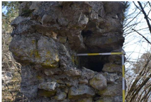
Figura 16: Castel Flavon, Flavon (TN). Sezione del muro di cinta dove permane traccia di una trave a sezione rettangolare disposta longitudinalmente alla sezione. Particolare.
