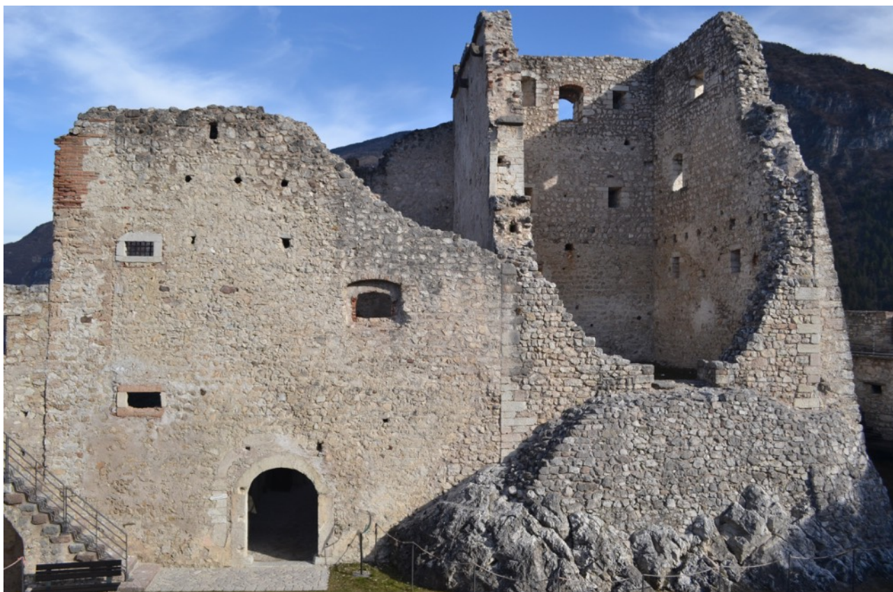
Figura 11: Castel Beseno, Besenello (TN). Complesso della casa-torre meridionale con muro est-ovest. Nella sezione del muro ovest della casa-torre, a livello del primo solaio è visibile traccia di una trave a sezione rettangolare.
