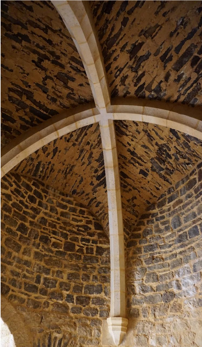
Figure 26: La voûte achevée. © Guédelon
