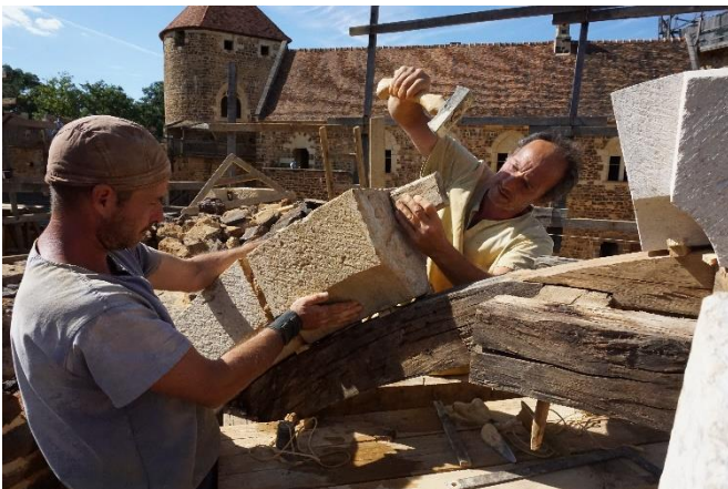
Figure 17: Tassement par percussion du mortier du joint. © Guédelon
