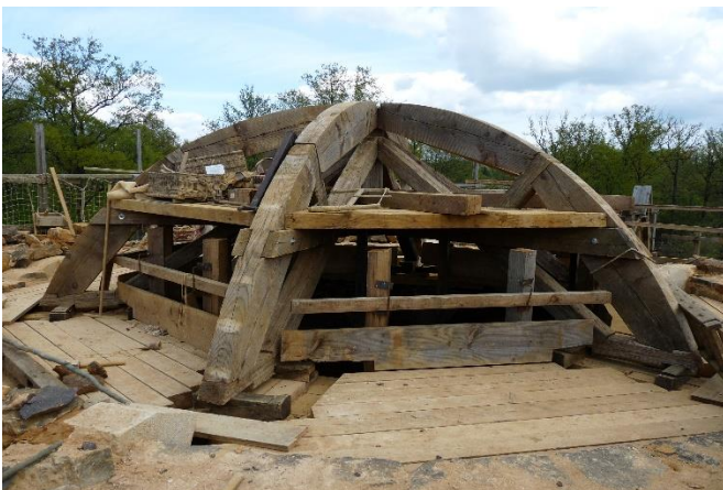
Figure 10: Montage des cintres destinés à porter les ogives. Implantés sur un échafaudage intérieur (cf. infra), les cintres sont mis en place à la hauteur du dernier bloc des tas de charge. Contrairement à ce que l'on représente couramment, ils dessinent donc un segment de cercle inférieur au demi-cercle formé par les ogives. Ils sont articulés avec deux platelages qui mettent les maçons à la bonne hauteur pour installer la clef de voûte (dernier platelage) et les claveaux (platelage inférieur). © Guédelon
