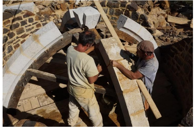
Figure 18: Vérification des alignements. © Guédelon
