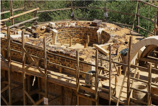
Figure 9: Montage des tas de charge à partir d'un plateau installé au niveau des culots. © Guédelon
