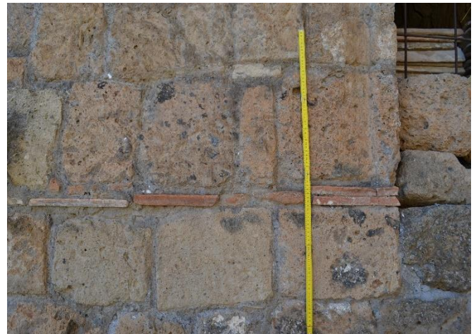
Figura 10: Contestualmente all'utilizzo di elementi di reimpiego, caratterizzati anche da fenomeni di erosione, si è documentata la pratica di inserimento di tavelle in cotto, talvolta frammentate, ai fini di regolarizzare la posa in opera e ridurre lo spessore del giunto di malta tra pietra e pietra.
