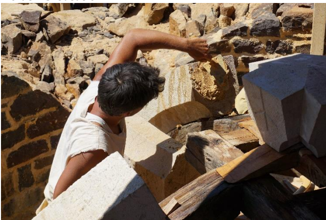
Figure 16: Dépose du mortier de joint. © Guédelon
