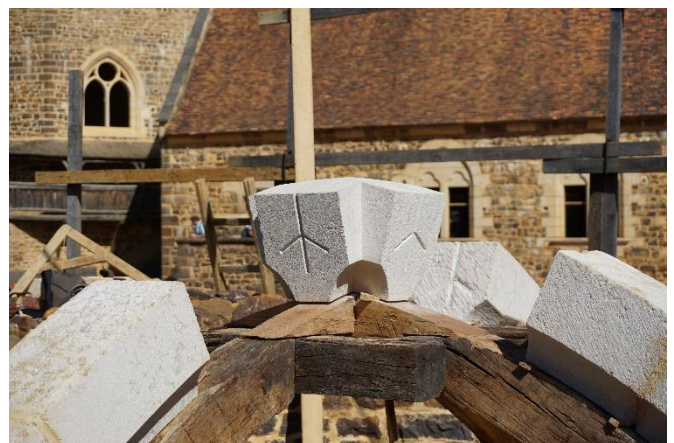
Figure 14: Montage des ogives. Les claveaux sont librement mis en place (ils peuvent être déplacés dans tous les sens pour faciliter le travail). Seule l'installation du dernier claveau de chaque ogive est une opération difficile, car le maçonnerie se fait sur des blocs mis en position définitive. © Guédelon
