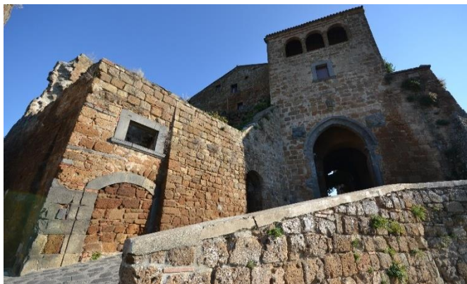
Figura 3: La consistenza muraria del centro storico e l'omogeneità del materiale posto in opera è uno dei primi caratteri costruttivi che emergono al momento del sopralluogo. Porta Santa Maria.
