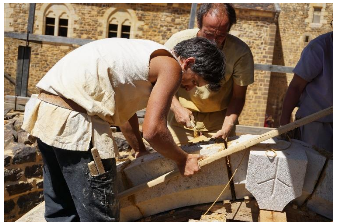
Figure 19: Mise en place du dernier joint, entre deux blocs - le dernier claveau et la clef - déjà en place. © Guédelon
