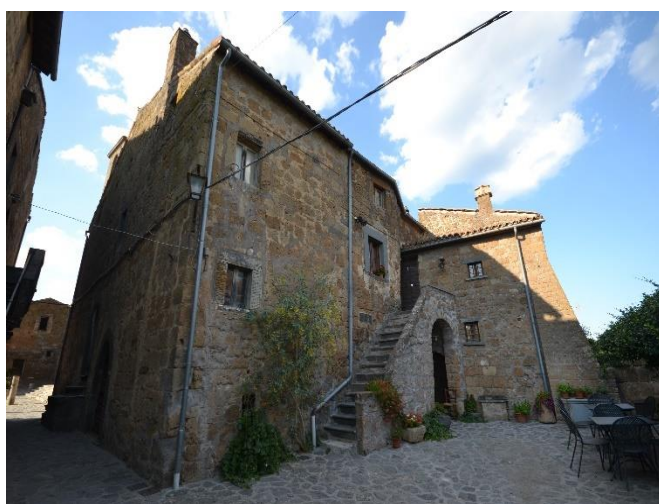
Figura 16: Complesso Architettonico campione. Vista sud-ovest.
