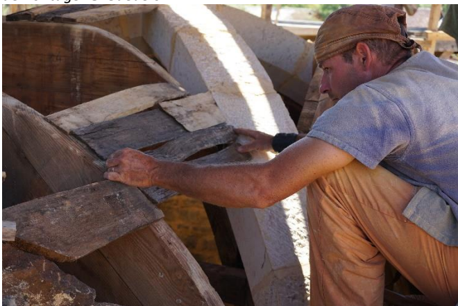
Figure 21: Installation sur l'ogive et un cintre des planchettes du coffrage devant porter le voûtain à réaliser. © Guédelon
