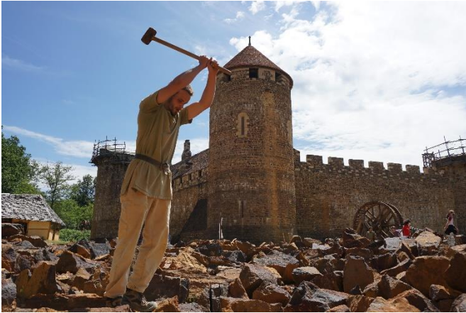
Figure 6: Débitage à la masse des blocs de grès sur le site du chantier. © Guédelon
