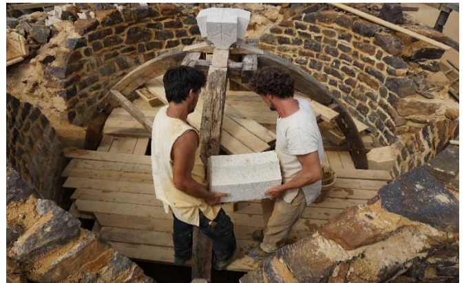
Figure 13: Installation d'un claveau. On remarque que la clef a été le premier élément de la voûte mis en place. © Guédelon
