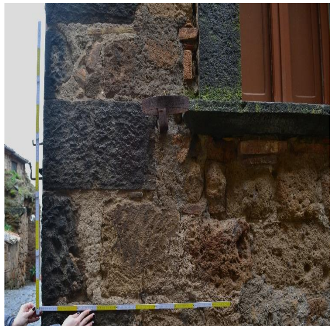
Figura 18: I cantonali dei corpi di fabbrica di quinta fase presentano un elevato grado di lavorazione della Leucite tefritica, gli elementi sono squadrate, spianati a punta e presentano nastrino perimetrale a scalpello piano.
