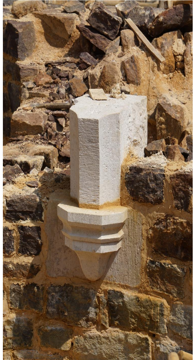
Figure 8: Insertion des culots des ogives dans les maçonneries. L'installation de ces premiers blocs répond à une géométrie très précise, puisque la position des culots détermine la régularité de toute la voûte, à la fois dans le tracé exact des ogives, dans le tracé des 4 demi-disques de maçonnerie où reposeront les 4 vouôtains. © Guédelon
