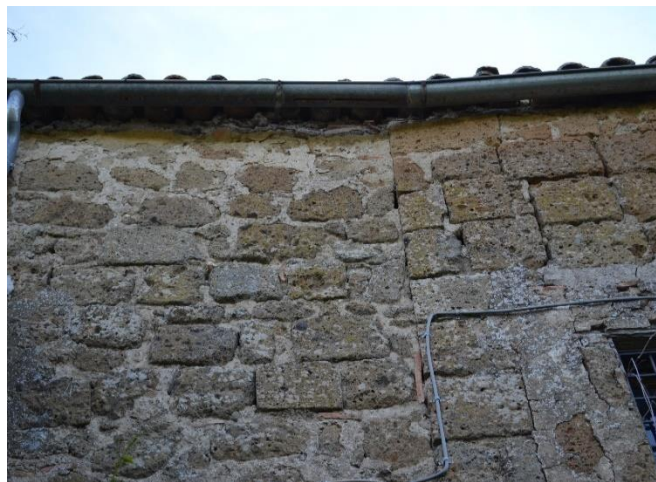
Figura 12: Limite stratigrafico di appoggio caratterizzato dalla costruzione dell'edificio di sinistra sfruttando la preesistenza. A sanare i vuoti si provvede, talvolta, anche all'inserimento di elementi di dimensioni minori e tavelle in cotto.
