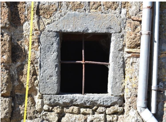
Figura 9: Elemento architettonico in Leucite tefritica, blocchi parzialmente squadrate e lavorati superficialmente a punta.
