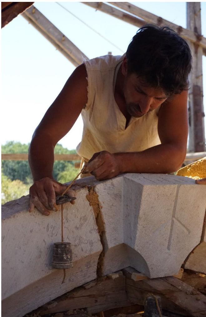
Figure 20: Vérification des verticales. Opération très délicate, parce qu'elle prend appui sur une surface très étroite, mais essentielle, pour éviter que l'ogive ne vrille, défaut qui nécessiterait un démontage. © Guédelon
