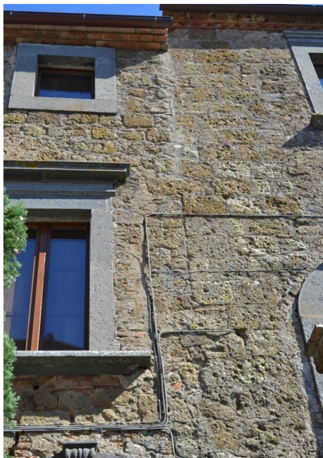
Figura 13: Corpi di fabbrica in ammorsamento. Si documenta anche nel caso di Civita la pratica di lasciare degli elementi sporgenti per la costruzione, in secondo cantiere, di edifici adiacenti.
