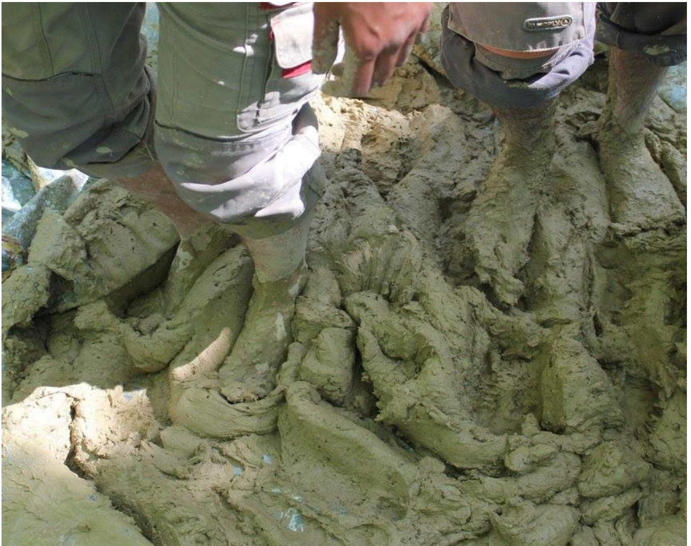
Figura 21: preparazione dell'impasto argilloso.
