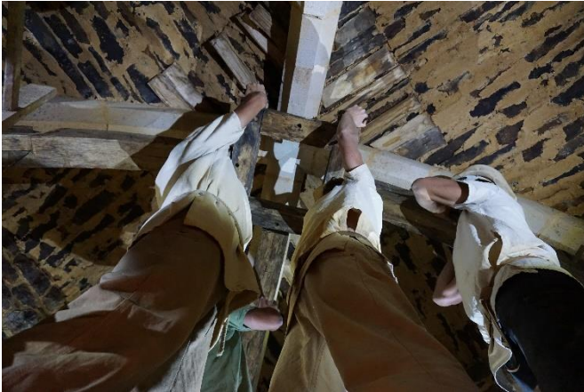
Figure 25: Démontage des cintres. Les planchettes positionnées près du sommet de la voûte restent bloquées. © Guédelon
