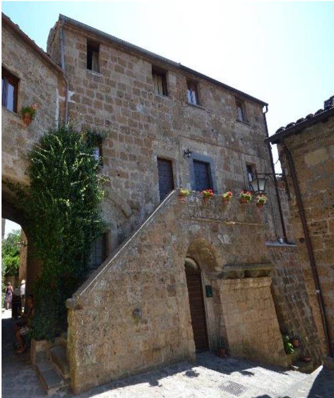
Figura 21: Un esempio di scala a profferlo, elemento costruttivo tipico del territorio viterbese, eretta in ammassamento sui paramenti esterni di due corpi di fabbrica del medesimo aggregato, obliterando un portale più antico, già precedentemente tamponato.
