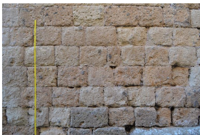
Figura 7: Nonostante l'erosione del blocco, sono documentati, anche in questo caso, la cura nel taglio della materia prima, la posa in opera e lo sfalsamento dei giunti verticali, con qualche incertezza rispetto al caso precedente (fig. 6).
