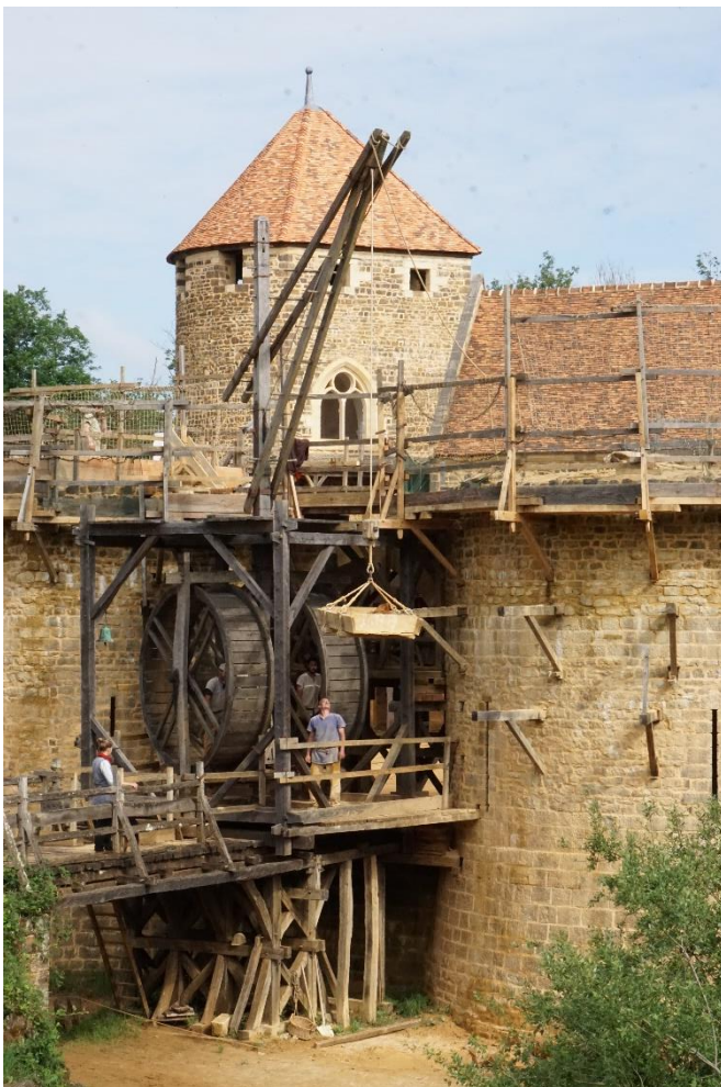
Figure 7: La tour d'entrée est de l'enceinte. En arrière-fond, la tour de la chapelle (fenêtre à remplage) et la toiture du logis. On remarque la très grande régularité des assises formant le fruit de la base. © Guédelon
