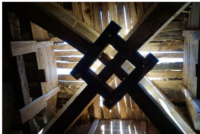
Figure 22: Cintres des ogives et coffrages des voûtains vus par-dessous. A noter le renforcement de l'assiette de la clef de voûte. © Guédelon
