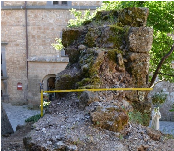
Figura 14: Sezione muraria a semisacco (due paramenti) con elementi di punta, parzialmente squadrate, in Ingimbrite. Il nucleo è costituito da malta, brecce e scapoli.
