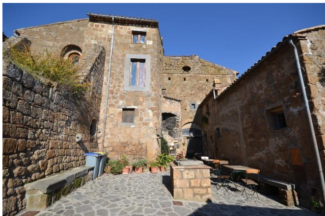
Figura 5: Lo stato di conservazione delle architetture di Civita consente di indagarne i materiali e le regole costruttive. Si osserva, anche nelle fasi più recenti, la tradizione locale dell'impiego generalizzato dell'ignimbrite.
