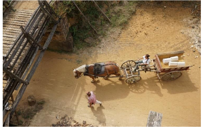
Figure 12: Transport de 4 claveaux par charroi. Les déplacements de charges lourdes à l'intérieur du chantier exigent un sol plat, exempt de ces irrégularités de terrain qui occasionneraient des accidents graves. Le chantier de Guédelon a permis de comprendre pourquoi, sur certains édifices, les premiers trous de boulin apparaissent très bas, à quelques dizaines de centimètres du sol: les platelages qu'ils supportaient offraient une surface de circulation sécurisée, contrairement au sol naturel, trop irrégulier. © Guédelon
