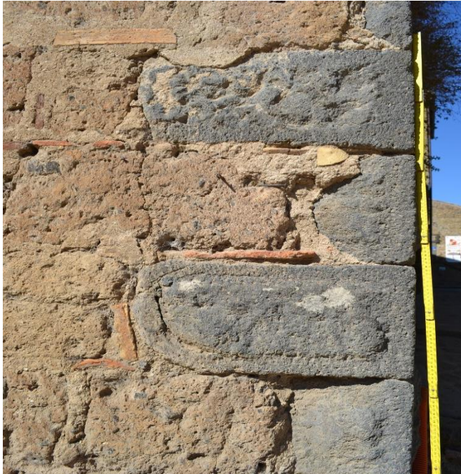
Figura 8: Il cantonale del medesimo corpo di fabbrica (fig. 7) denota l'ammorsamento dei muri ortogonali mediante l'impiego di elementi in Leucite tefritica parzialmente squadrate, bugnati e lavorati con nastrino perimetrale a scalpello piano. L'apparecchiatura è alternata testa/fascia.
