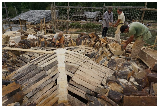
Figure 23: Le coffrage achevé. On notera qu'il n'est pas nécessaire de faire joindre exactement les planchettes. On remarquera aussi la forme donnée à la voûte d'ogives est encore légèrement bombée, caractère qui disparaîtra dans le courant du XIIIe siècle. © Guédelon
