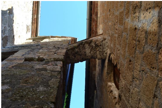
Figura 23: Arco di sbadacchio tra corpi di fabbrica pertinenti a complessi architettonici diversi.
