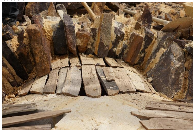
Figure 24: Mise en place des blocs formant les voûtains. Il s'agit de dalles petites et étroites, disposées en éventail. Elles n'ont pas nécessairement de forme trapézoïdale, pour assurer le clavage: c'est le mortier posé au montage qui les bloque les unes les autres et assure la fonction de clavage. Puis la chape de mortier qui recouvrira
