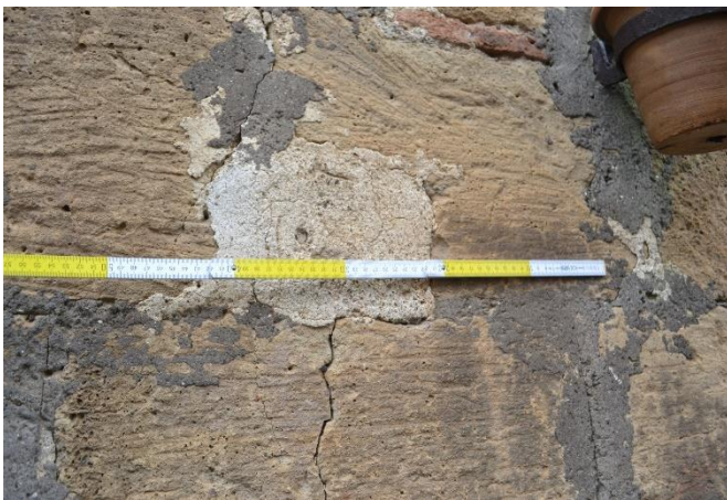
Figura 17: Lavorazione superficiale dei conci impiegati nella casa torre di prima fase, gli elementi in Ignimbrite presentano tracce, talvolta molto regolari, di lama liscia, forse pertinenti ad uno strumento ad ascia documentato anche in altri studi di area regionale.
