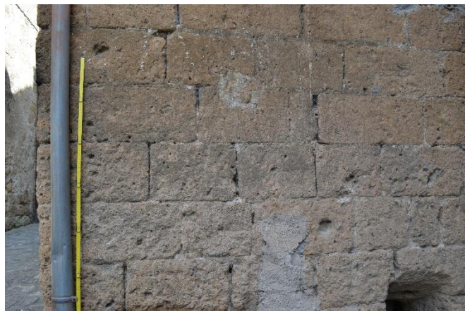
Figura 6: L'opera quadrata isodoma che interessa paramenti e angolate di questo corpo di fabbrica denota una particolare attenzione nello sfalsamento dei giunti verticali.
