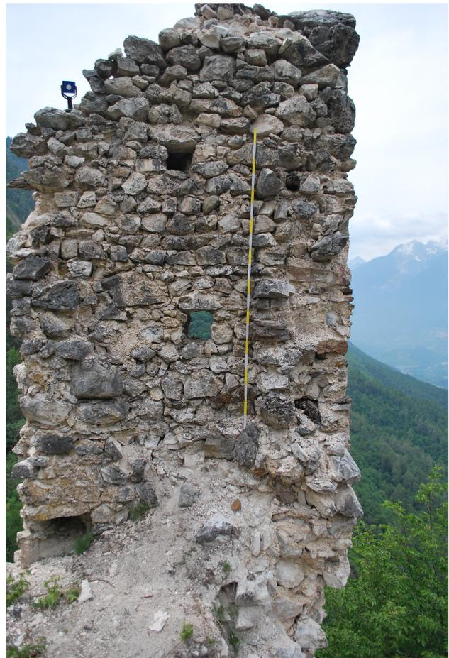
*Figura 18: Castel San Pietro, Vigo di Ton (TN). Sezione dell'edificio addossato alla prima cinta che presenta conservate in situ travi a sezione circolare ad intervallo di 1,5 m.*
