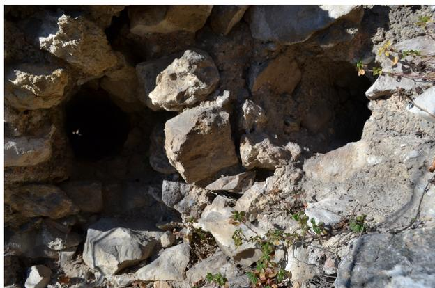
Figura 9: Castel Barco, Pomarolo (TN). Sezione della cinta sommitale con le tracce lasciate dal sistema di rinforzo ligneo con travi a sezione circolare. Particolare.
