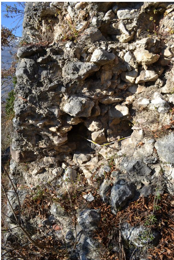
Figura 8: Castel Barco, Pomarolo (TN). Sezione della cinta sommitale con le tracce lasciate dal sistema di rinforzo ligneo con travi a sezione circolare.
