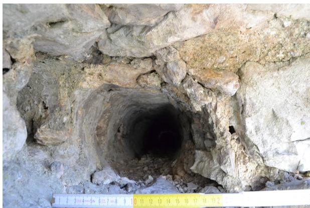
Figura 10: Castel Barco, Pomarolo (TN). Sezione della cinta sommitale con le tracce lasciate dal sistema di rinforzo ligneo con travi a sezione circolare. Particolare.
