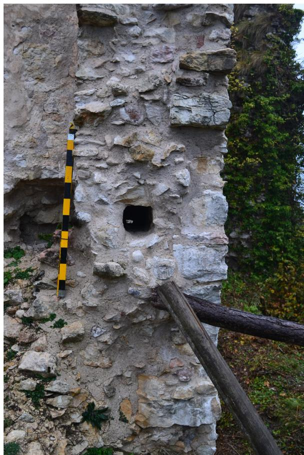
Figura 13: Castel Gresta, Pannone (TN). Sezione dell'edificio IV con traccia di trave a sezione rettangolare.
