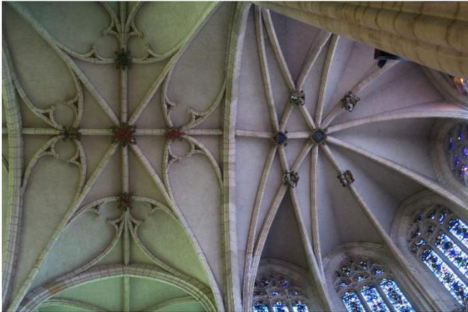
Figure 4: Saint-Nizier de Lyon, voûtes de l'abside et du chœur (fin XVe): un défaut d'implantation dans le pan sud de l'abside a occasionné un gauchissement vers le sud de la clef de la voûte, gauchissement mis en évidence visuellement par le lierne. Cliché N. Reveyron.
