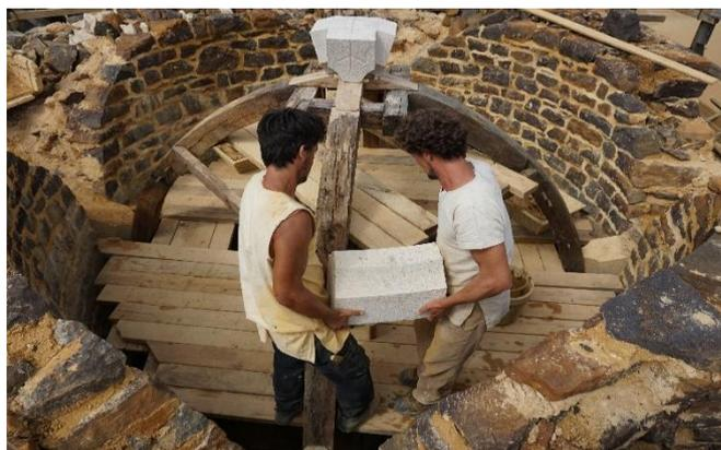
Figure 13: Installation d'un claveau. On remarque que la clef a été le premier élément de la voûte mis en place. © Guédelon
