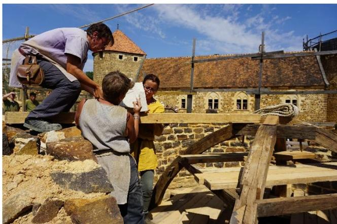
Figure 11: Réception de la clef de voûte. Le bloc est déposé par-dessus le mur, sur un long bastaing, puis sera tiré par glissement jusqu'à son emplacement. © Guédelon
