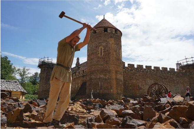
Figure 6: Débitage à la masse des blocs de grès sur le site du chantier.
