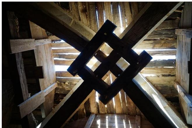
Figure 22: Cintres des ogives et coffrages des voûtaines vus par-dessous. A noter le renforcement de l'assiette de la clef de voûte. © Guédelon
