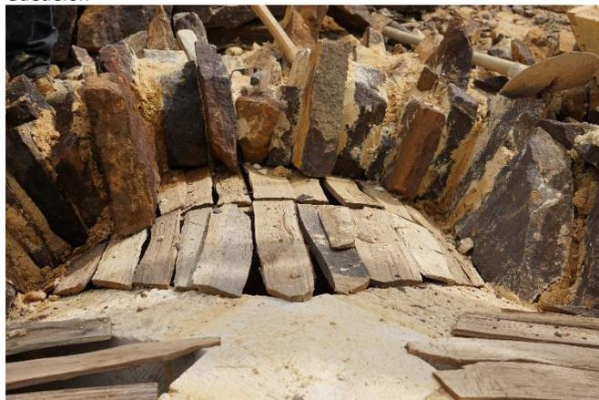
Figure 24: Mise en place des blocs formant les voûtaines. Il s'agit de dalles petites et étroites, disposées en éventail. Elles n'ont pas nécessairement de forme trapézoïdale, pour assurer le clavage: c'est le mortier posé au montage qui les bloque les unes les autres et assure la fonction de clavage. Puis la chape de mortier qui recouvrira
