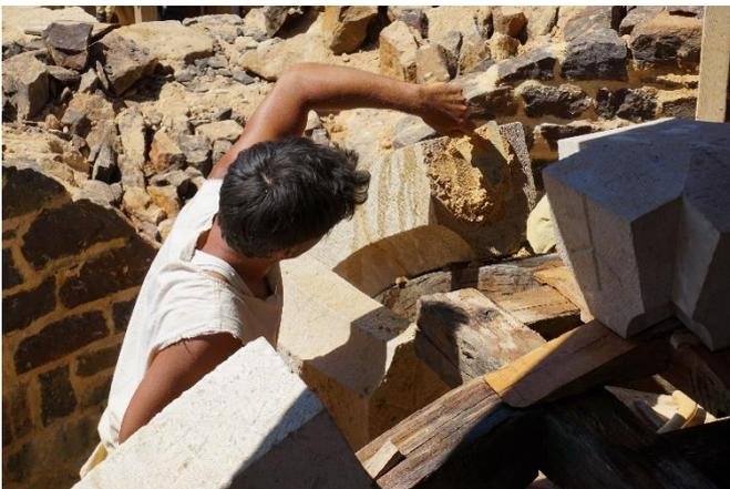
Figure 16: Dépose du mortier de joint. © Guédelon
