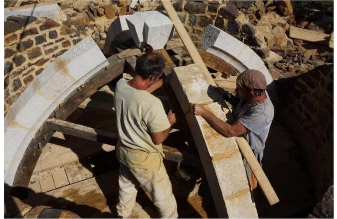
Figure 18: Vérification des alignements. © Guédelon
