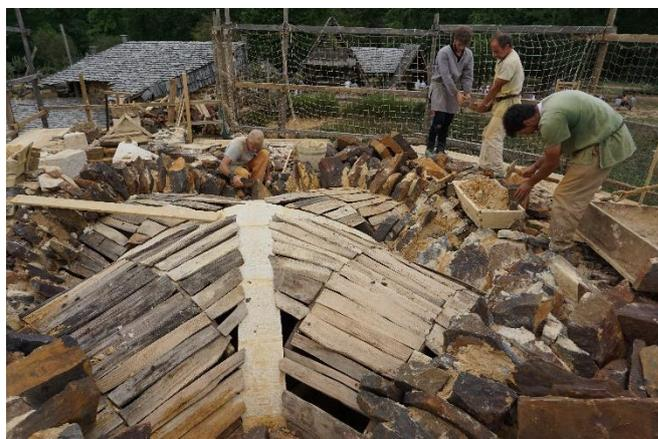
Figure 23: Le coffrage achevé. On notera qu'il n'est pas nécessaire de faire joindre exactement les planchettes. On remarquera aussi que la forme donnée à la voûte d'ogives est encore légèrement bombée, caractère qui disparaîtra dans le courant du XIIIe siècle. © Guédelon
