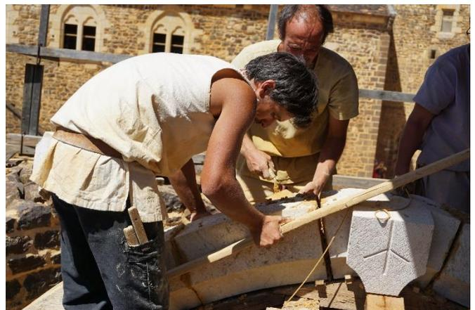
Figure 19: Mise en place du dernier joint, entre deux blocs - le dernier claveau et la clef - déjà en place. © Guédelon
