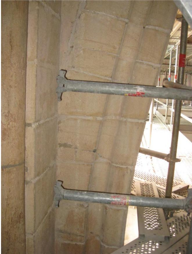
Figure 1: Cathédrale de Lyon, tas de charge dans les voûtes sexpartites de la nef centrale (ogive centrale). Le tas de charge atteint ici une hauteur considérable de quelque 2 m. Cliché N. Reveyron.
