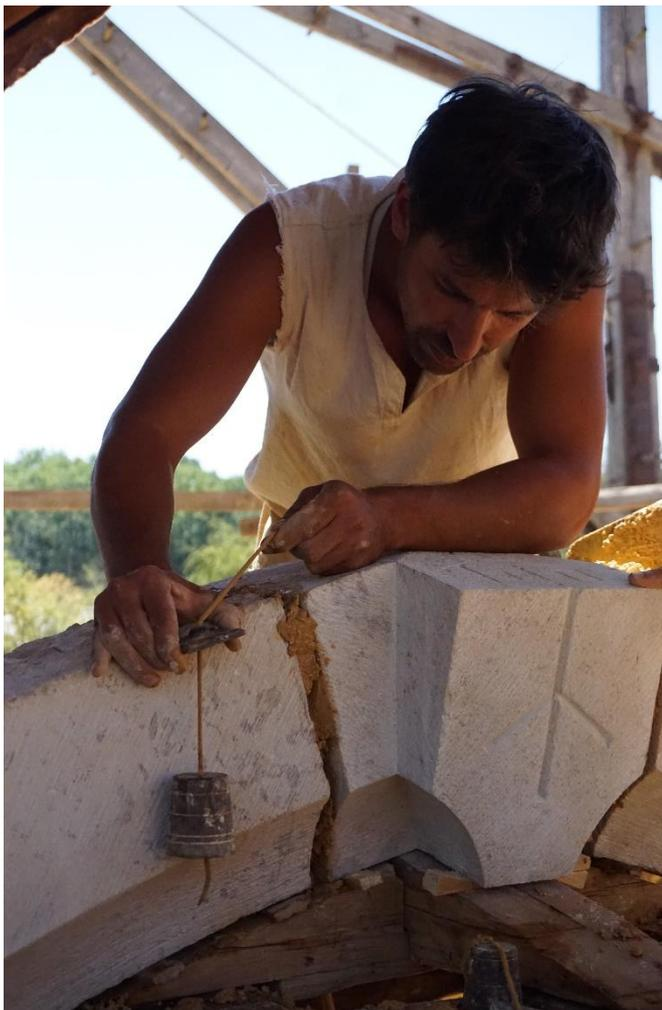
Figure 20: Vérification des verticales. Opération très délicate, parce qu'elle prend appui sur une surface très étroite, mais essentielle, pour éviter que l'ogive ne vrille, défaut qui nécessiterait un démontage. © Guédelon
