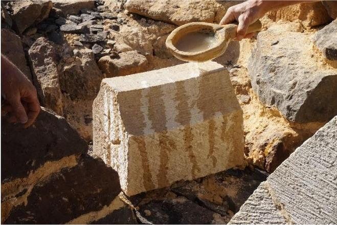
Figure 15: Humidification d'un claveau, destinée à assurer une bonne prise en main (en éliminant la poussière) et une bonne prise du mortier. © Guédelon
