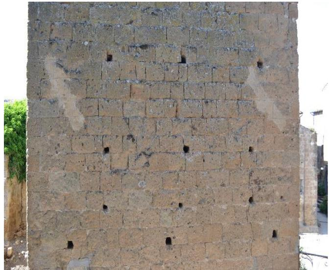
Figura 22: Torre dell'ex Palazzo Comunale. Tracce del paletto non più esistente degli incatenamenti interni in corrispondenza del primo livello.
