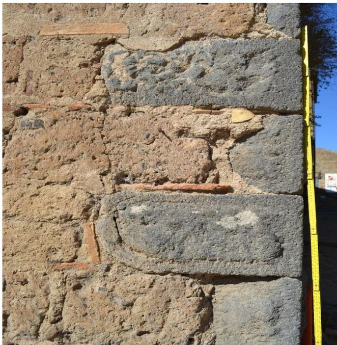
*Figura 8: Il cantonale del medesimo corpo di fabbrica (fig. 7) denota l'ammorsamento dei muri ortogonali mediante l'impiego di elementi in Leucite tefritica parzialmente squadrate, bugnati e lavorati con nastrino perimetrale a scalpello piano. L'apparecchiatura è alternata testa/fascia.*
