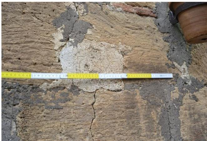
Figura 17: Lavorazione superficiale dei conci impiegati nella casa torre di prima fase, gli elementi in Ignimbrite presentano tracce, talvolta molto regolari, di lama liscia, forse pertinenti ad uno strumento ad ascia documentato anche in altri studi di area regionale.
