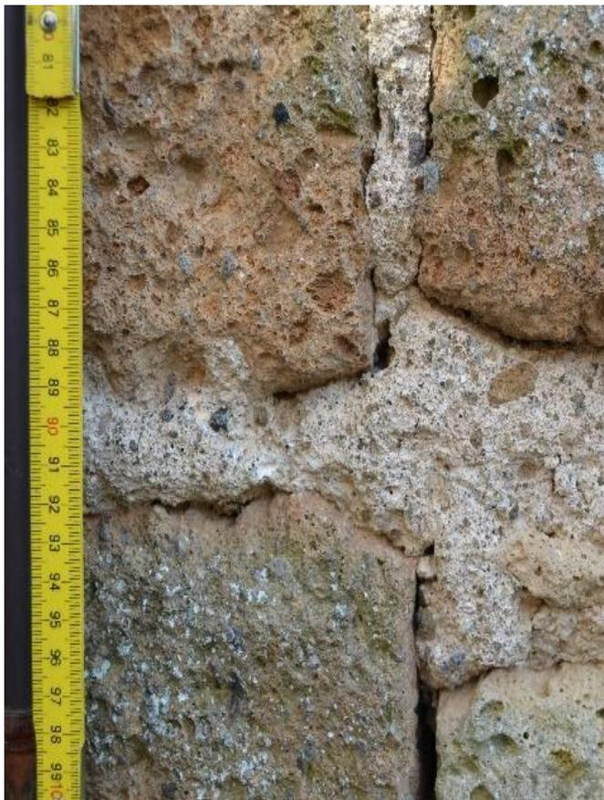
*Figura 11: La malta di connesura presenta macroscopicamente una matrice chiara, tono caldo, con calcinarioli e aggregati di dimensioni anche molto varie interpretabili, in prima analisi, come frammenti di Ignimbrite ed elementi a comportamento pozzolanico che si possono cogliere anche nelle tasche dei contigui blocchi di Ignimbrite.*
