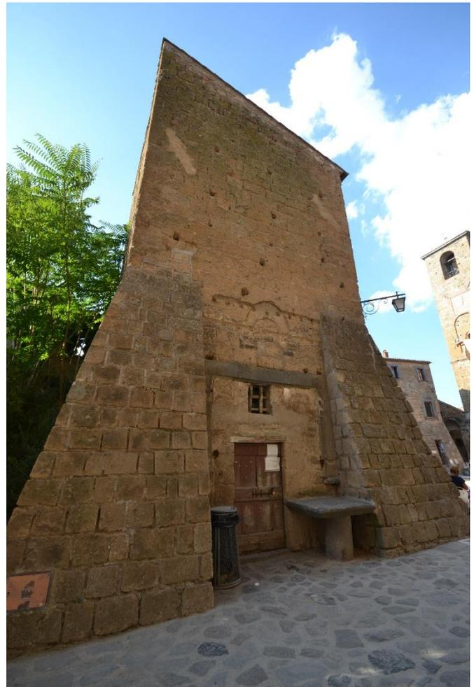
Figura 20: Presidi antisismici angolari dell'Ex Palazzo Comunale, complesso architettonico molto trasformato e caratterizzato da un parziale stato di rudere.
