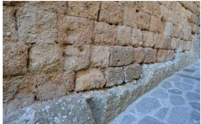
Figura 2: Dettaglio della fondazione di un corpo di fabbrica, direttamente impostata sullo strato roccioso di Ignimbrite O-B.
