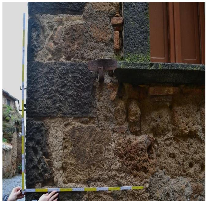
Figura 18: I cantonali dei corpi di fabbrica di quinta fase presentano un elevato grado di lavorazione della Leucite tefritica, gli elementi sono squadrate, spianati a punta e presentano nastrino perimetrale a scalpello piano.
