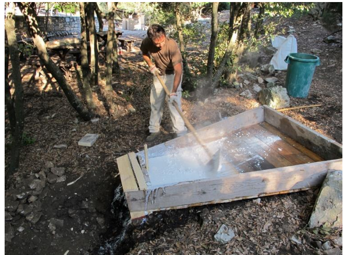
Figura 16: La masta per lo spegnimento della calce viva.
