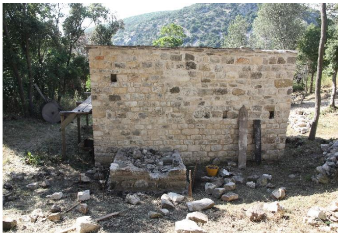
Figura 21: Le fondazioni del forno sul retro della casa.
