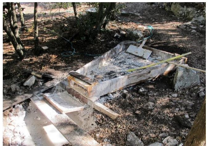
Figura 17: La calcinaia scavata per l'accumulo e la sedimentazione della calce spenta.
