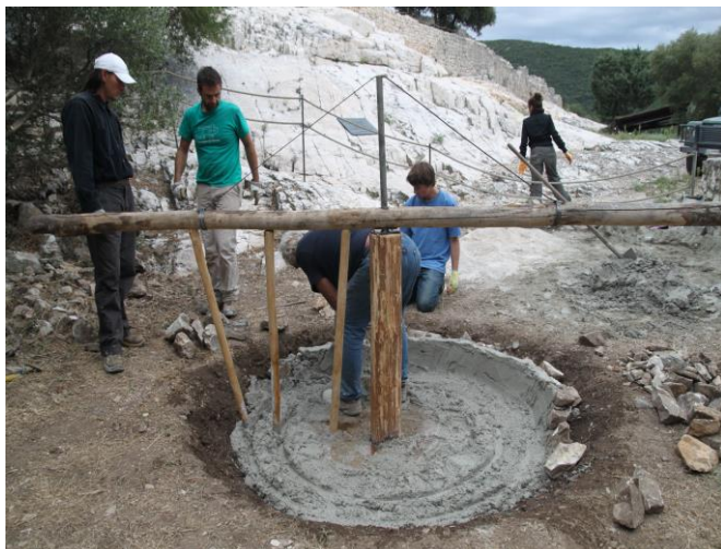
Figura 3: Le tracce impresse sul fondo della vasca del miscelatore in corso di costruzione.
