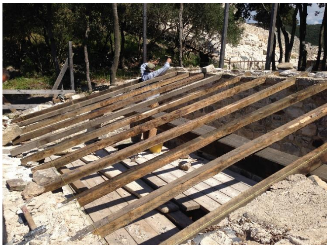
Figura 12: Intelaiatura lignea per il tetto.
