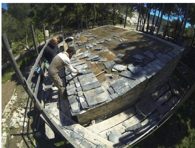
Figura 13: Copertura del tetto in lastre di ardesia.
