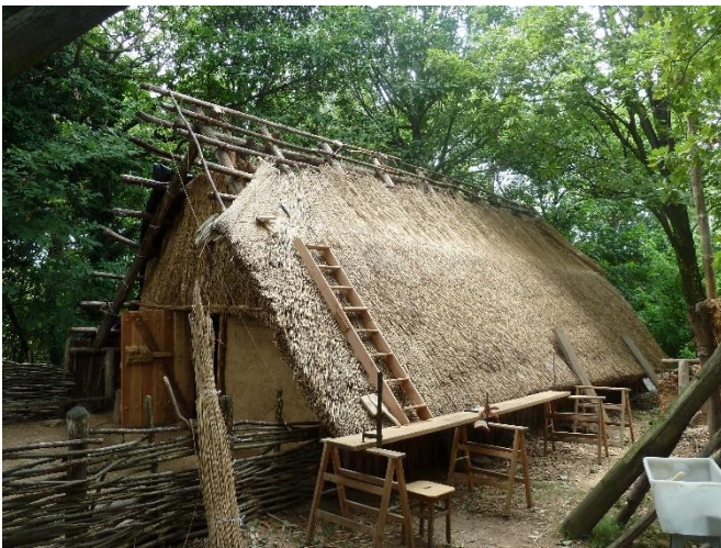
Figura 2: Realizzazione della copertura di una capanna di grandi dimensioni.
